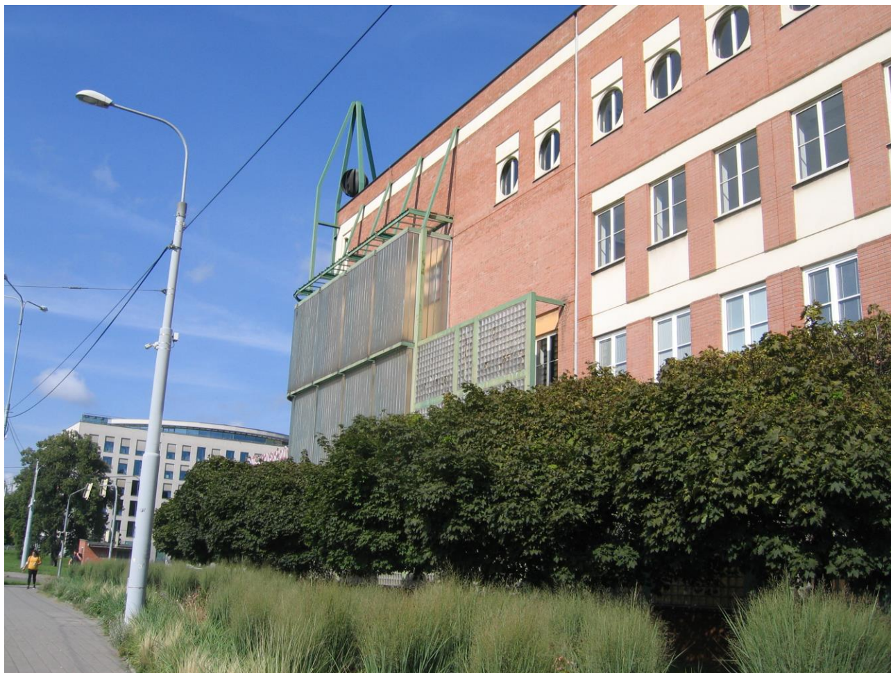
Jižní strana objektu konzervatoře
